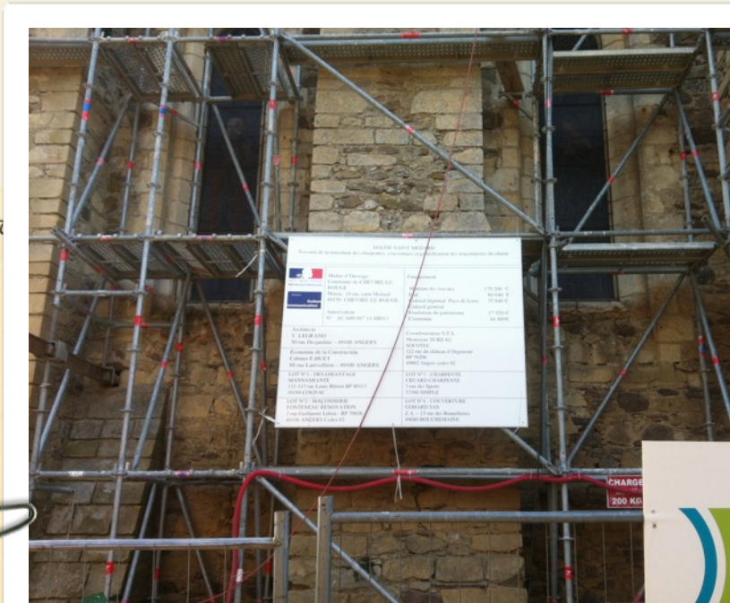
L'échafaudage installé autour du chœur de l'église...
